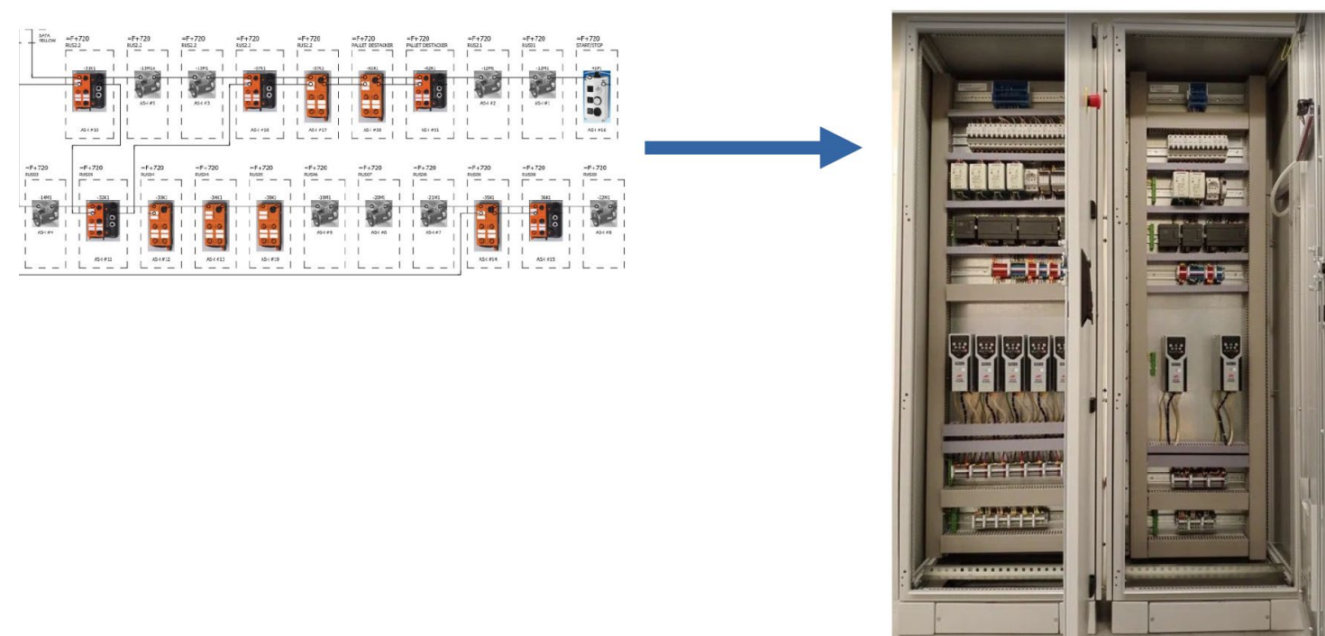
AS-Interface Станция ввода вывода UNIMAT в сети PROFINET UN 267-0AA00-0XA0 + модули UNIMAT серии UN200
